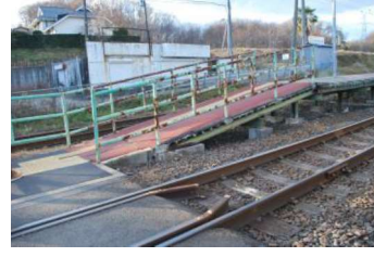
⑤スロープ・誘導用ブロック
