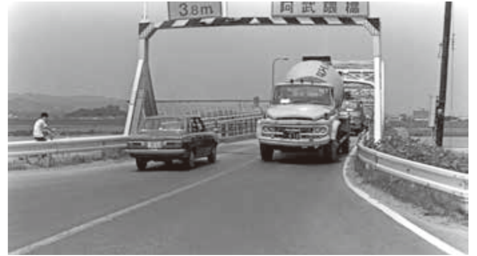
昭和52年頃の旧阿武隈橋
